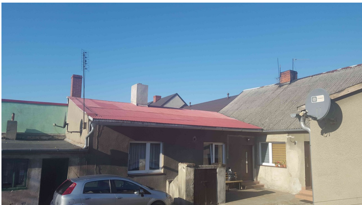
Fot. 3 Dach z blachy trapezowej nad przybudówką od strony zachodniej
