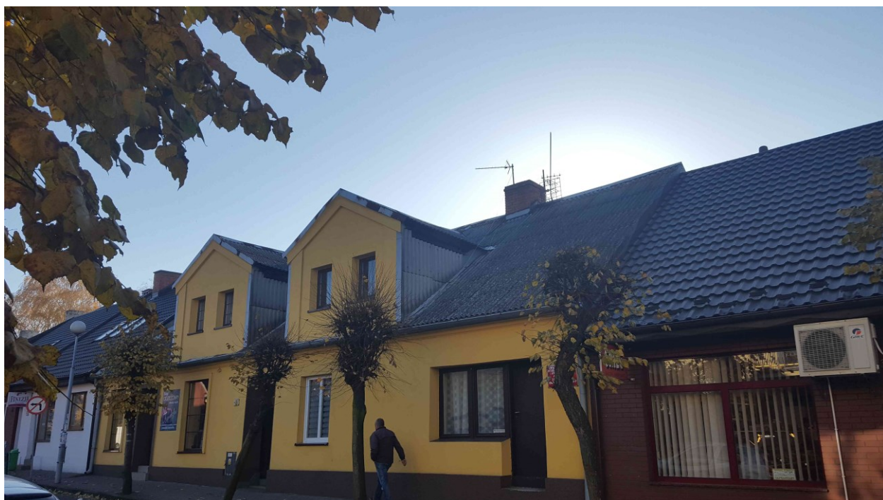
Fot. 1 Elewacja frontowa – od strony ulicy Kościuszki
