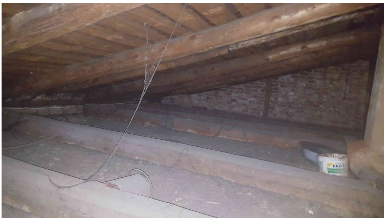
Fot. 6 Więźba dachowa nad nadbudówką od strony zachodniej.
