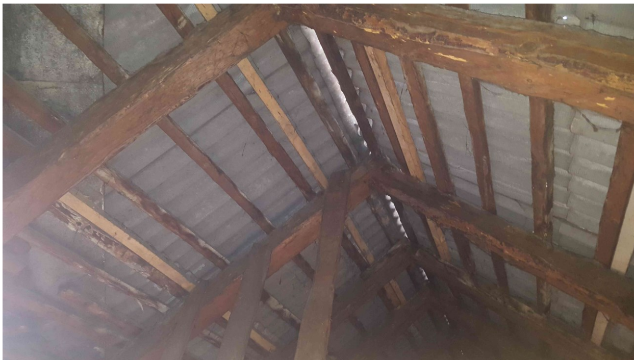
Fot. 5 Fragment więźby dachu głównego
