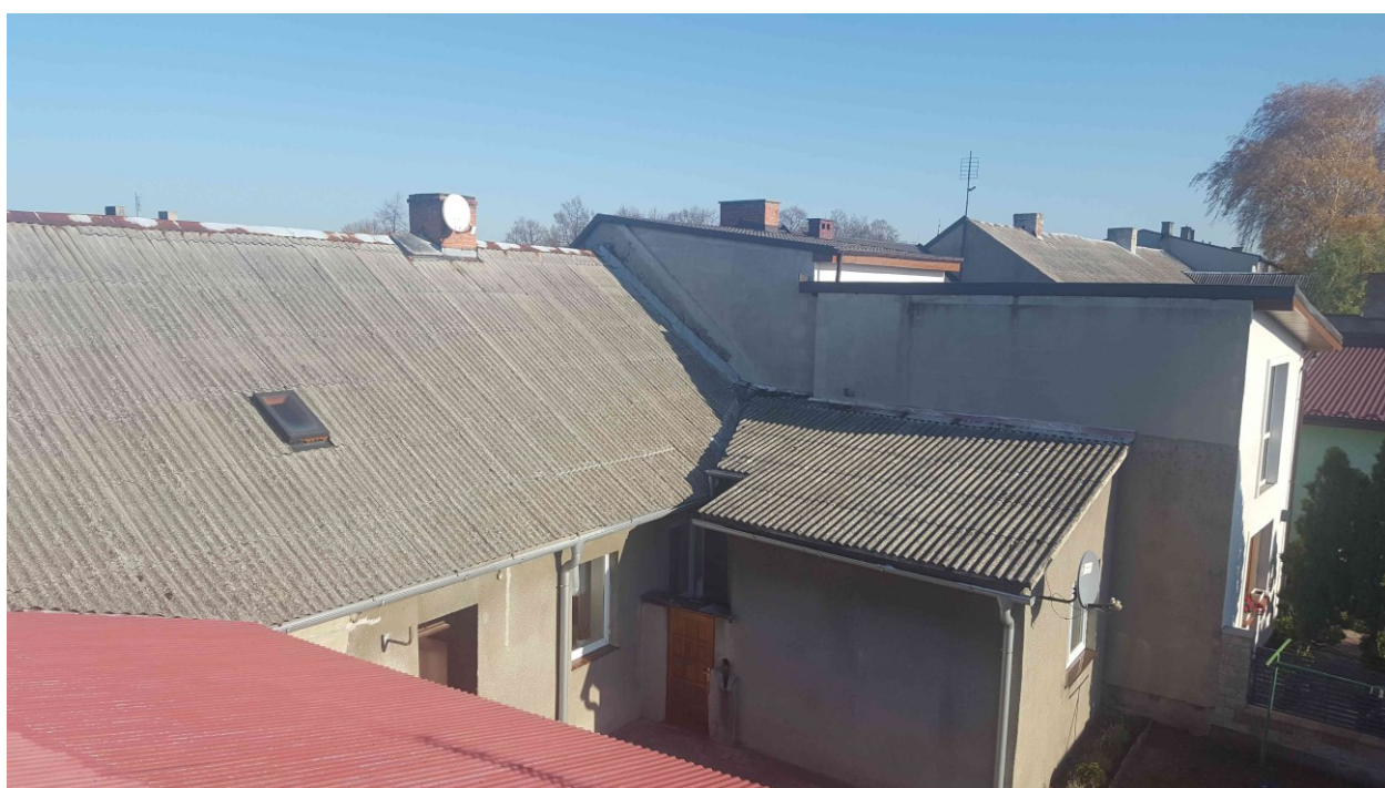
Fot. 2 Dach główny oraz dachy przybudówek od strony podwórza
